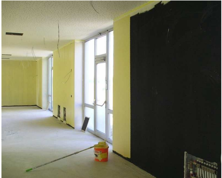
Entlang der Außenwände und bei einigen Leichtbauwänden wurde ein Abschirmanstrich verwendet.
